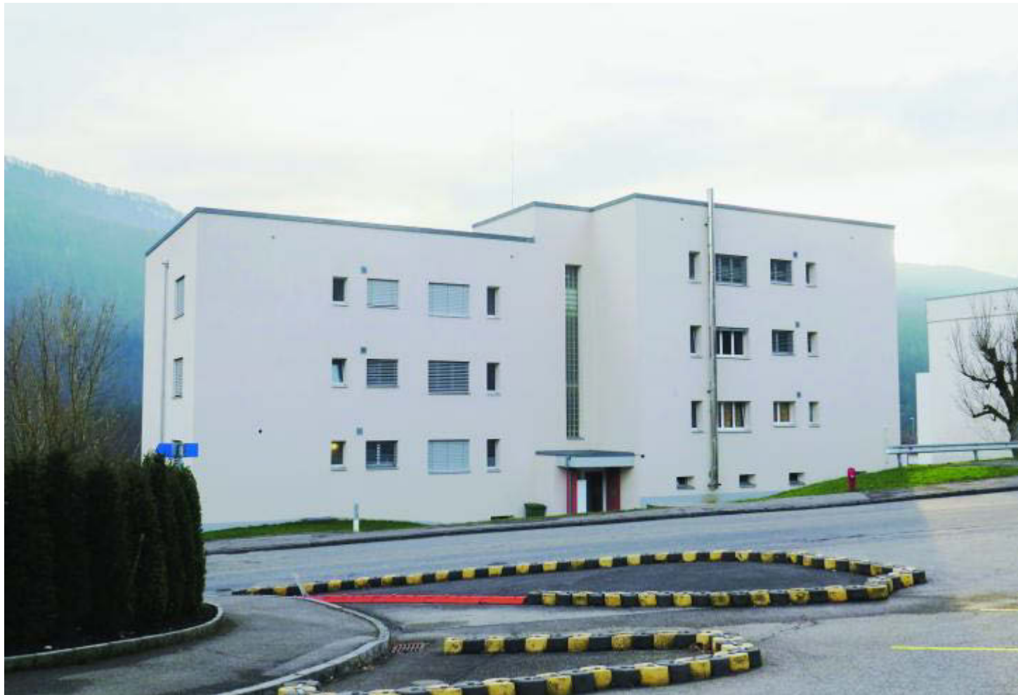
L'immeuble sur le toit duquel devrait, selon les plans soumis par Salt aux autorités prévôtoises, être construite une antenne téléphonique haute de cinq mètres, se trouve à la rue des Chênes 1. A quelques dizaines de mètres, en effet, de l'école enfantine et primaire de Chantemerle. ADRIAN VULIC
